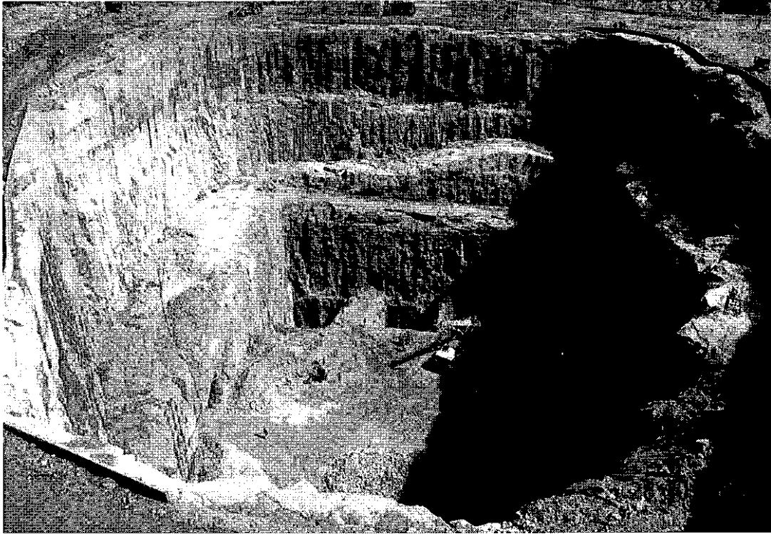
Figura 01 – Imagem da câmara de carga da Usina Hidrelétrica Governador Jayme Canet Junior.
